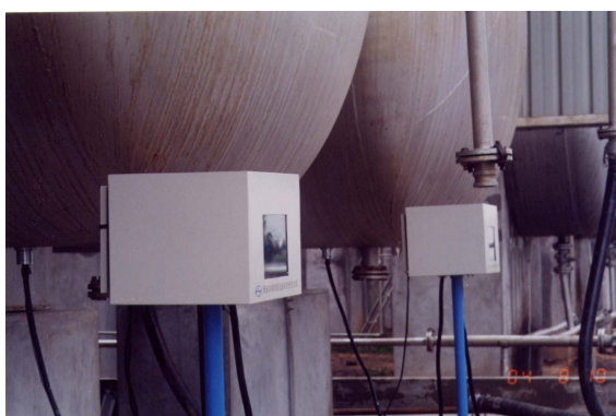
液位计在卧式罐上安装图片
