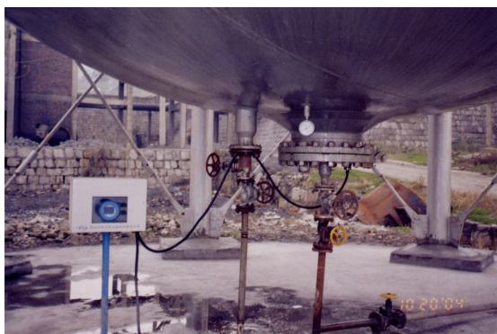
液位计在球罐上的液位测量图
