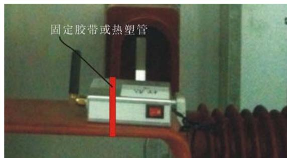
5.2 如果测量的是触头温度, 或者是电缆搭界头的温度。此时的温度测量发射模块带有一根长度为 30CM 的高温导线, 温度探头接在这条高温导线上 (导线的耐受温度为 250°, 导线可以接触铜排); 安装分两个步骤: 5.2.1 先把温度探头 (也就是导线头上的不锈钢圆柱) 安装到要测温度点上, 温度探头要充分和要测量温度点的金属部分接触 (不一定要按装在特定的点上, 在点附近就可以了, 因为金属的热传导性是很好的, 短距离内温度基本相同。譬如要测量断路器动触头的温度, 就没有必要非把点放在动触头的莲花头里面去, 把测温点放到静触头处就可以了)。下图为测量断路器触头温度时的安装照片:
