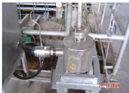
小型反应釜安装
